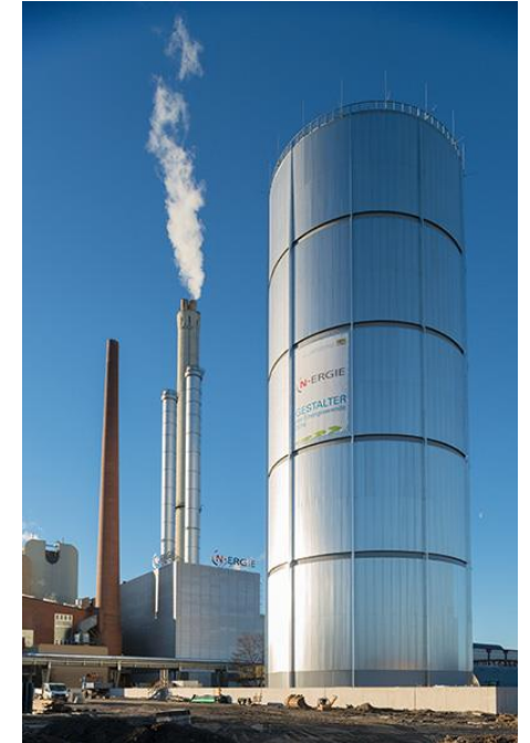
Fernwärmespeicher Nürnberg Sandreuth, 1,5 GWh, 120 °C
